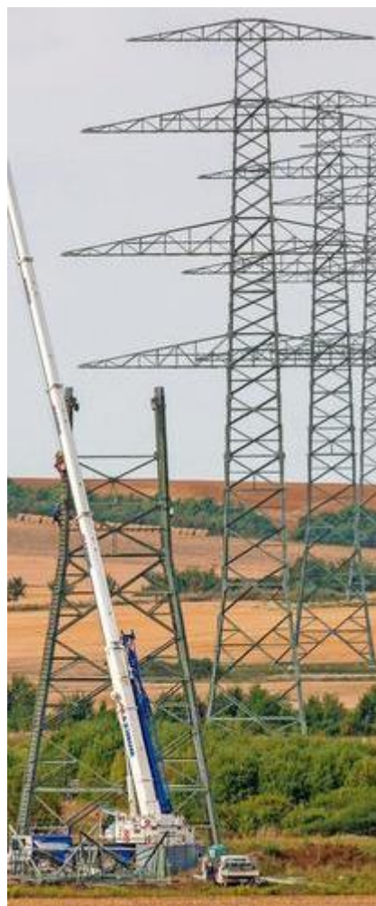
Die Energiewende wird sichtbar: Bei Arnstadt entstehen die riesigen Masten der neuen 380 000-Volt-Leitung. Sie soll über den Rennsteig geführt werden und dann den Süden Deutschlands mit Windstrom aus dem Norden versorgen, sagt die Branche. Kritiker halten die 380-kV-Trasse für zumindest überdimensioniert und argwöhnen, sie diene vor allem dazu, aus Kohle gewonnenen Strom zu verteilen. Foto: ari
